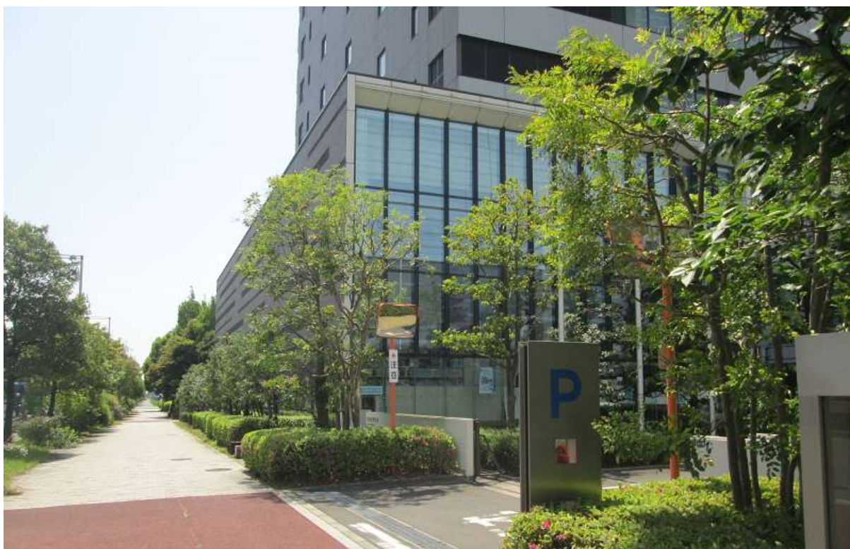
図1. 上：テレコムセンター駅の周辺地図、下：海上保安庁海洋情報部青海庁舎。
